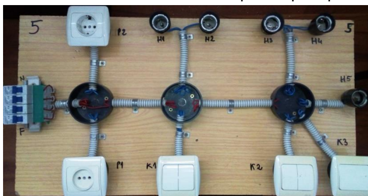
Figura 1.13 Panoplie demonstrativă cu instalație de iluminat și prize
